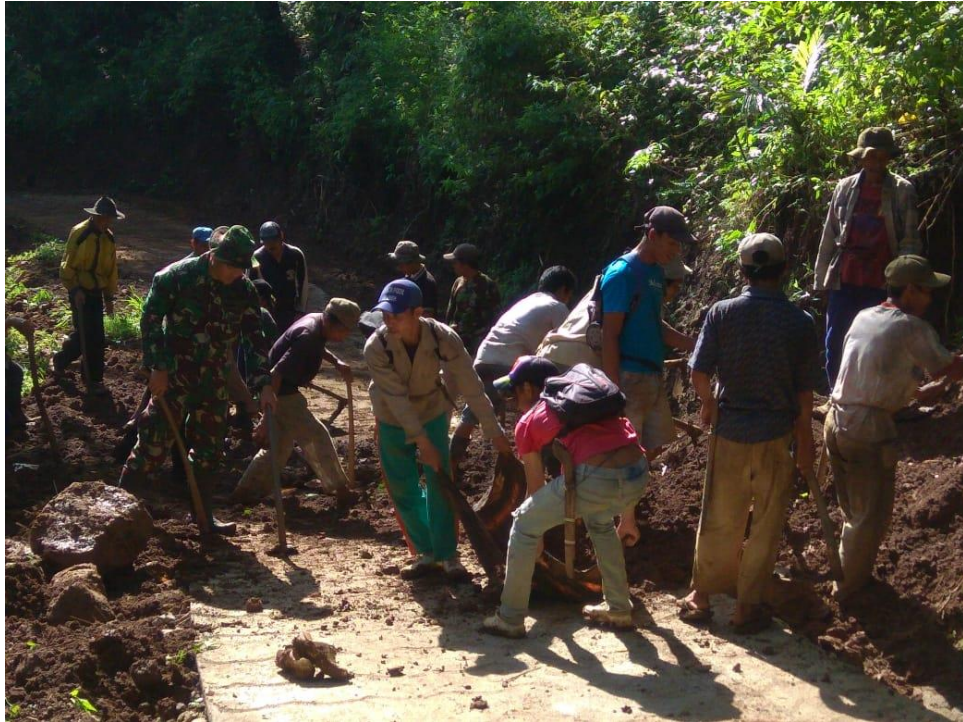
Membersihkan Longsor tanah di Desa Cikuya. Kp Cidulang Dusun Pancatengah
